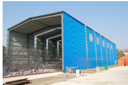
图 4-2 钢筋切割隔声棚
