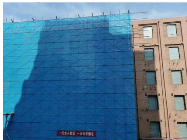
图 4-3 外墙装修隔声
